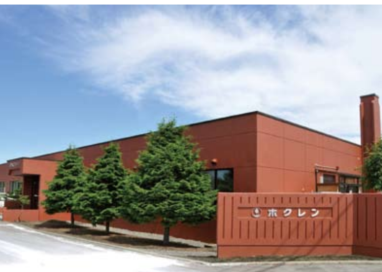
農業総合研究所 バイオ研究センター（夕張郡長沼町）
